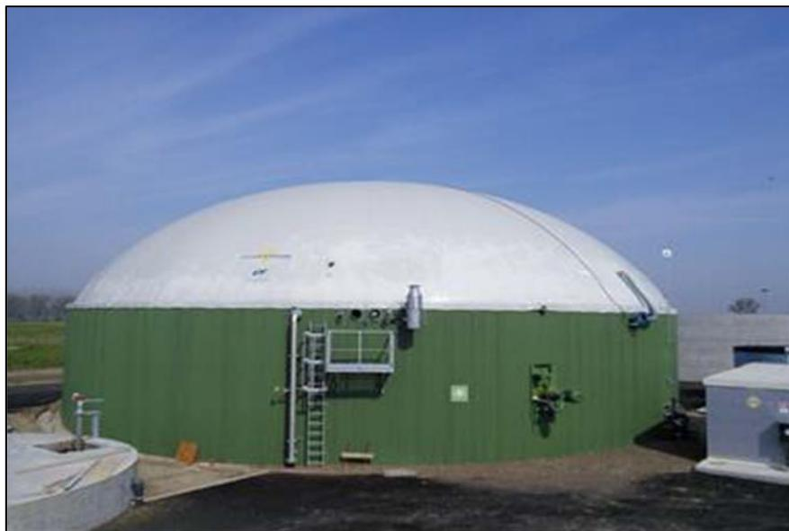
Si tratta di una vasca monolitica circolare in calcestruzzo gettato in opera, avente diametro di 25 m, altezza utile pari 8 m (fuoriterra per 7.2 m) e capacità geometrica di c.a. 3900 m<sup>3</sup>. Avrà le seguenti caratteristiche:
