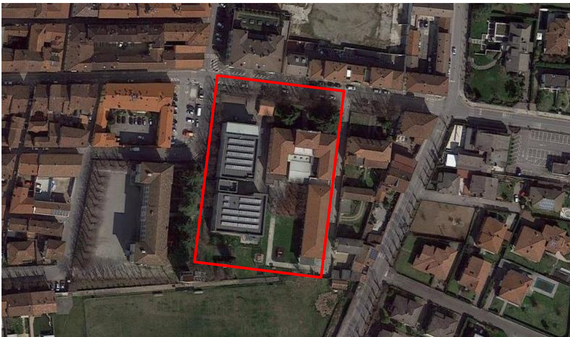
Aula polifunzionale Istituto Comprensivo Orzinuovi – Via Mazzini
